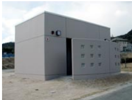
H26.1 高等学校屋外施設新築電気工事
