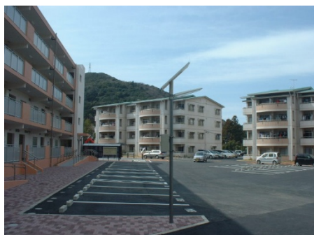
H25.9 県営団地外構整備・その他街灯導入施工
