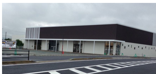
H25.4 新築電気工事
